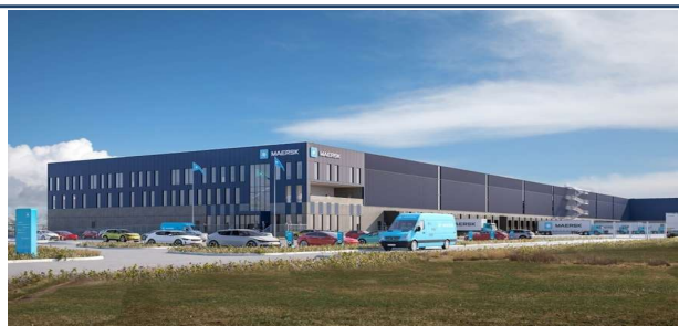
Maersk 콜드체인 물류창고
