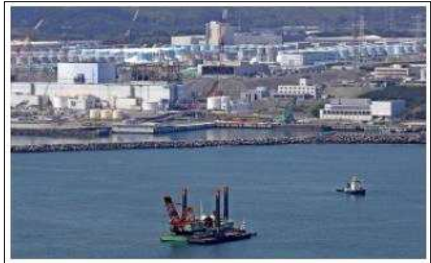
그림 11. 오염수 방류용 해저터널 굴착공사를 위한 준설선
