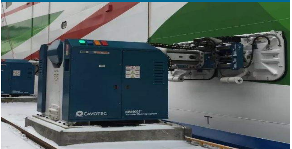
핀란드 헬싱키 항만에 설치된 Cavotec사의 자동 계류 시스템
