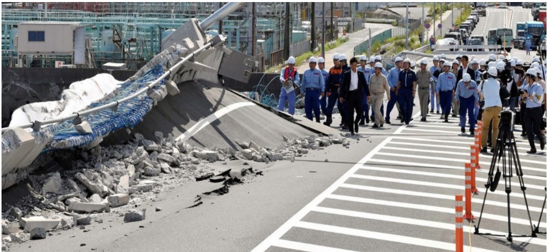
그림 Ⅲ-5 2019년 제15호 태풍 파사이로 표류한 플로팅 도크로 파손된 요코하마 항만진입 교량 모습
