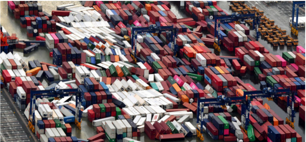
그림 Ⅲ-4 2018년 제21호 태풍 제비로 인한 폭풍해일로 큰 피해를 입은 고베항
