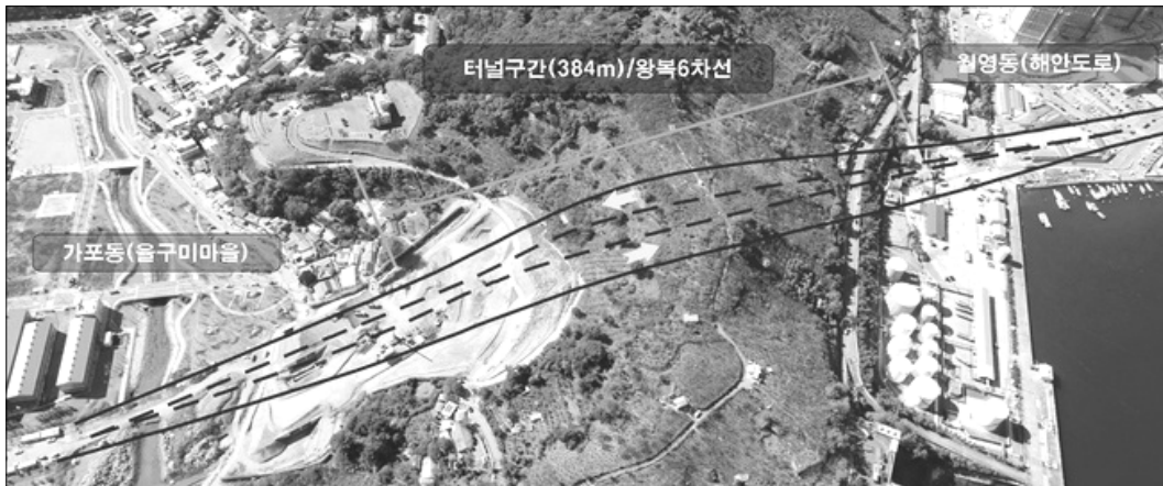
그림 II-3 마산항 진입도로 건설사업 2-1단계, 가포신항터널 구간
