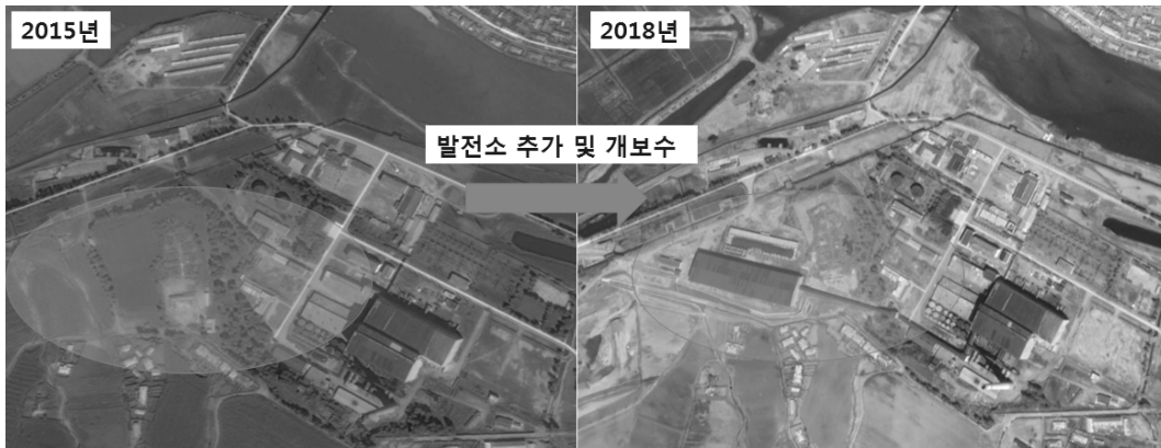
그림 Ⅲ-10 선봉화력발전소 신규 공사
