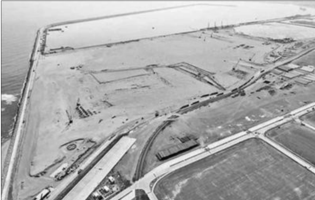
그림 II-4 건설중인 베라크루즈 신항 전경
