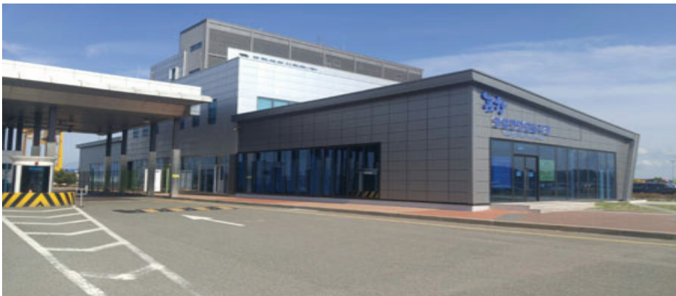
〈그림 11-2〉 포항영일만항 출입국시설
