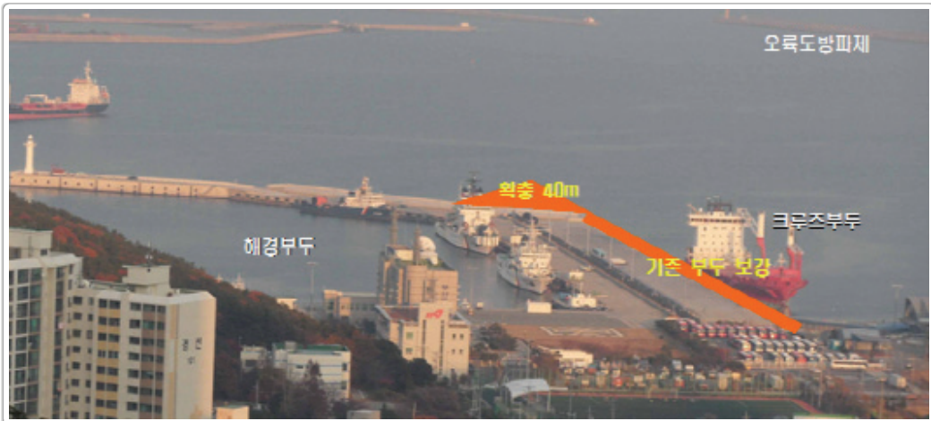
〈그림 III-12〉 부산항 동삼동 크루즈부두 확장 현장
