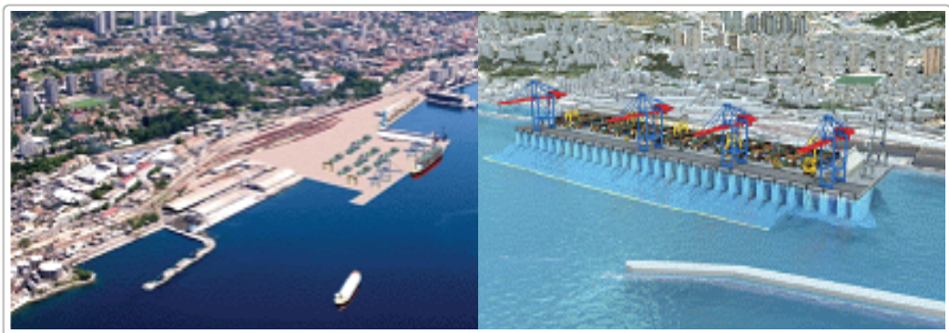
〈그림 Ⅱ-2〉 1단계 공사완료 후(左), 2단계 공사완료 후(右)
