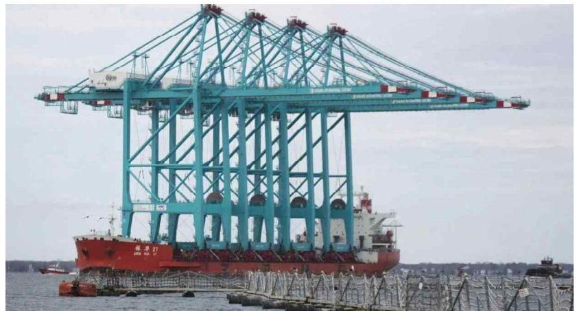
그림 3. 미국 항구에 설치된 중국산 크레인
