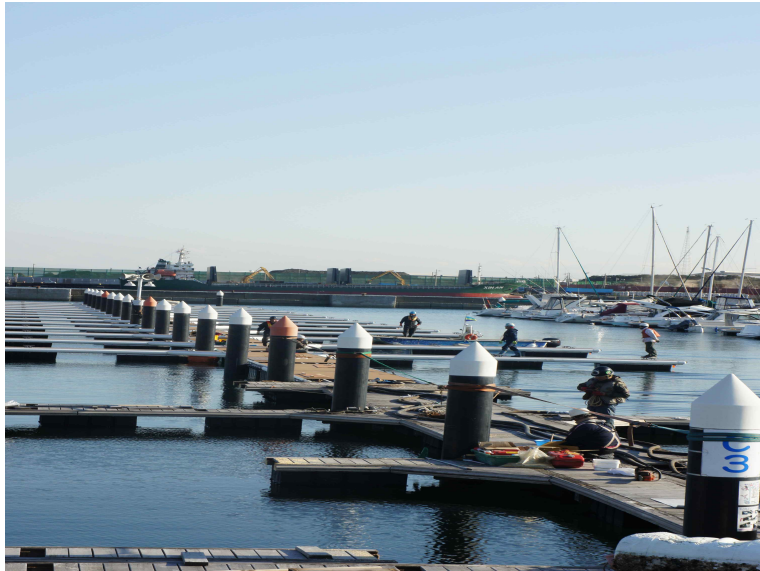
<그림 IV-9> YBM 요트 정박시설 공사현장
