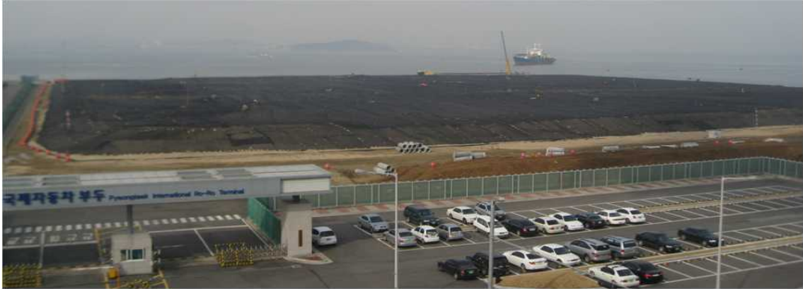
<그림 V-9> 평택국제자동차 12번 부두 공사 현황(5월)
