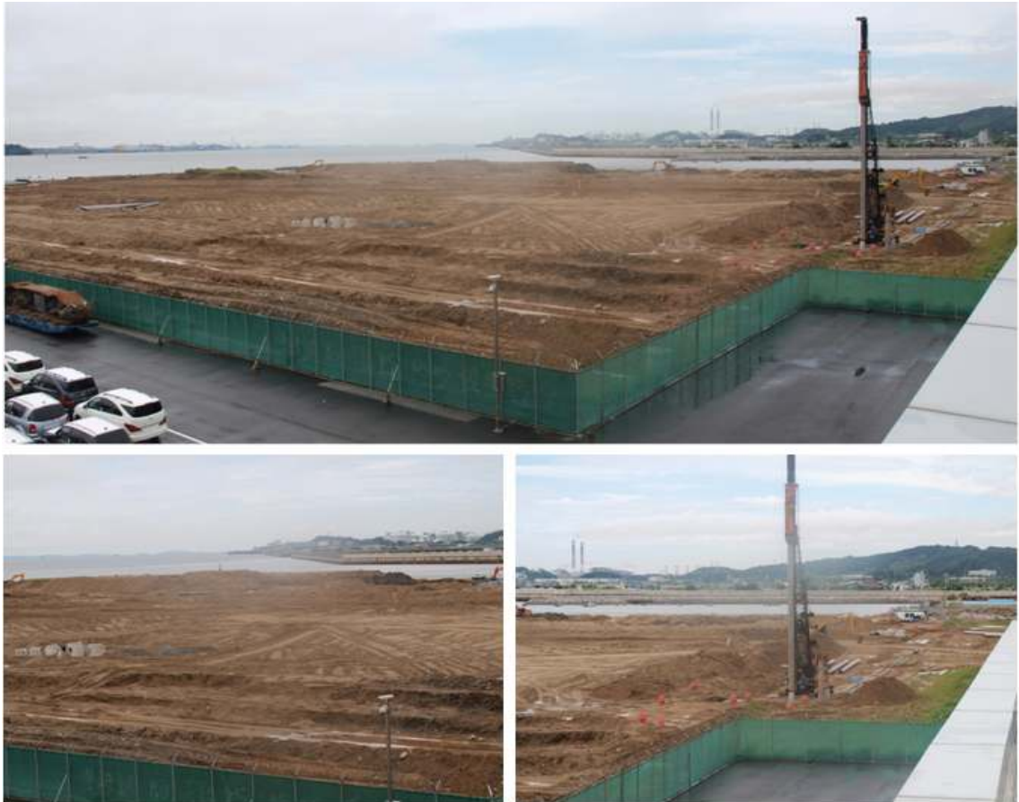
<그림 V-10> 평택국제자동차 12번 부두 공사 현황(8월)
