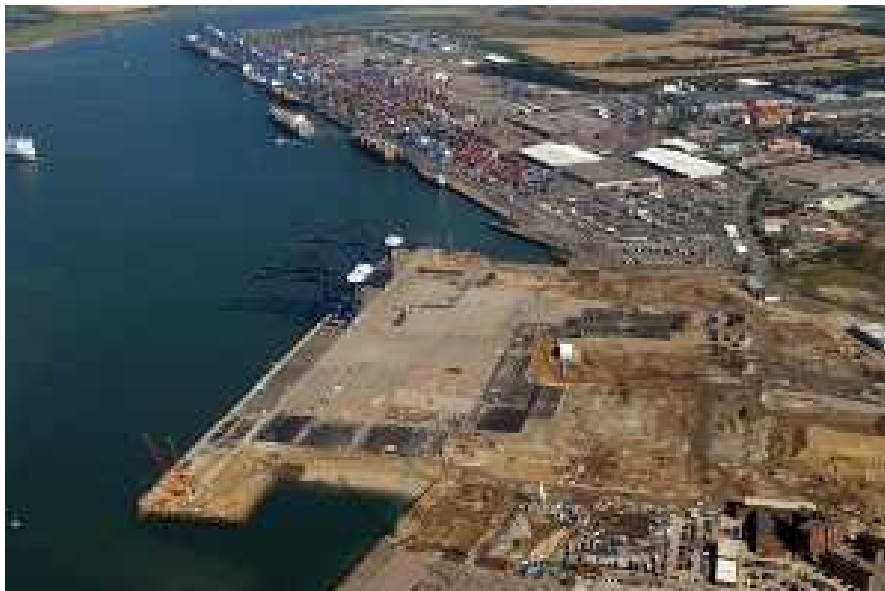
<그림 II-1> FSR 1단계 건설 현황
