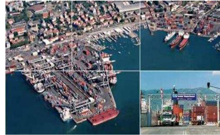
&lt;그림 부록 1-4&gt; 라스페치아항 La Spezia Container Terminal 현황
