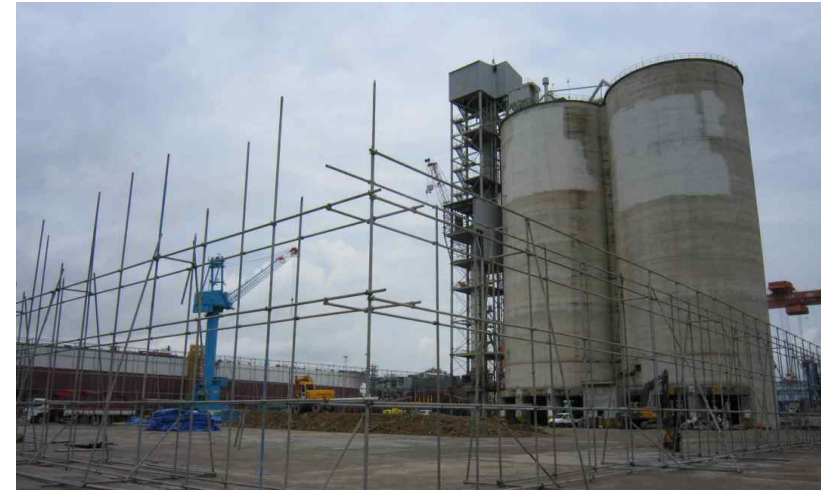
&lt;그림 V-30&gt; 철거전인 목포항 현대삼호부두 시멘트 시설
