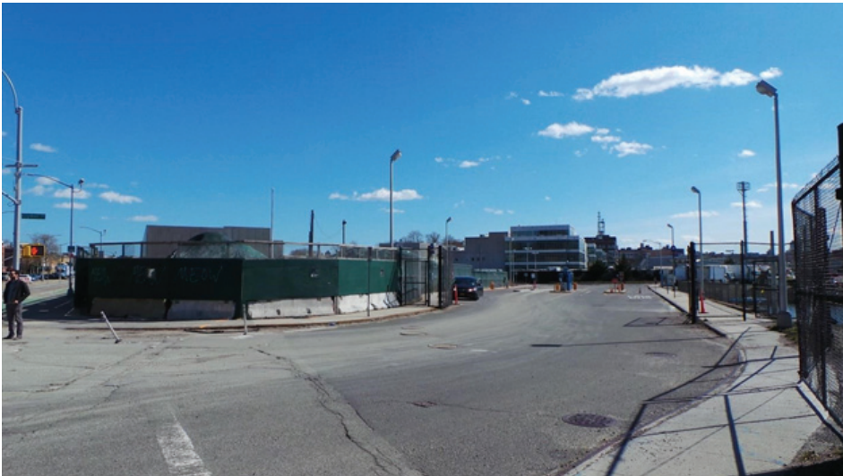
〈그림 3-16〉 스테이너 스튜디오 확장 공사 현장
