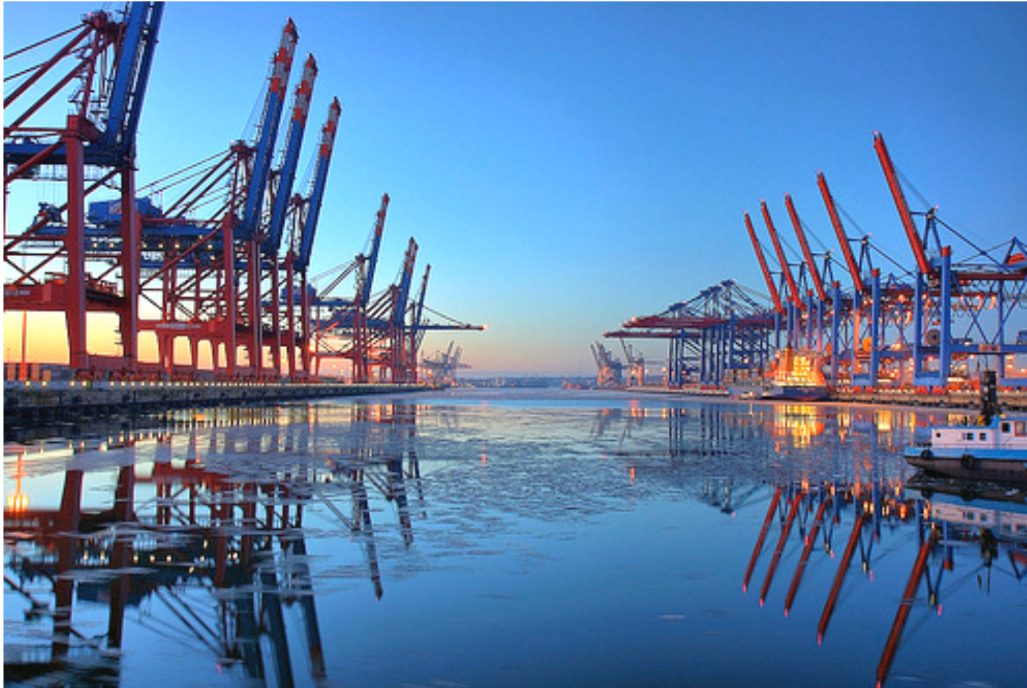
CTB-CTW Container Terminal Burchardkai, Port of Hamburg-Waltershof
