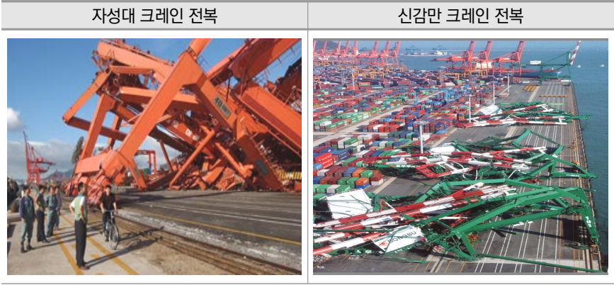
〈그림 3-1〉 태풍 매미에 따른 부산항 북항 터미널 피해 모습
