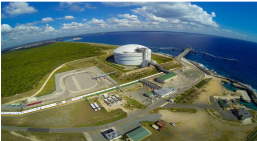
〈그림 4-6〉 산토도밍고 인근 LNG 발전소 배후 부지
