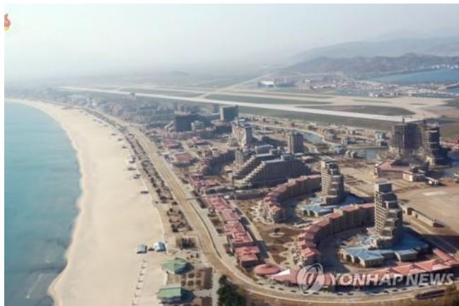
〈그림 2-4〉 원산 갈마해안관광지구 전경
