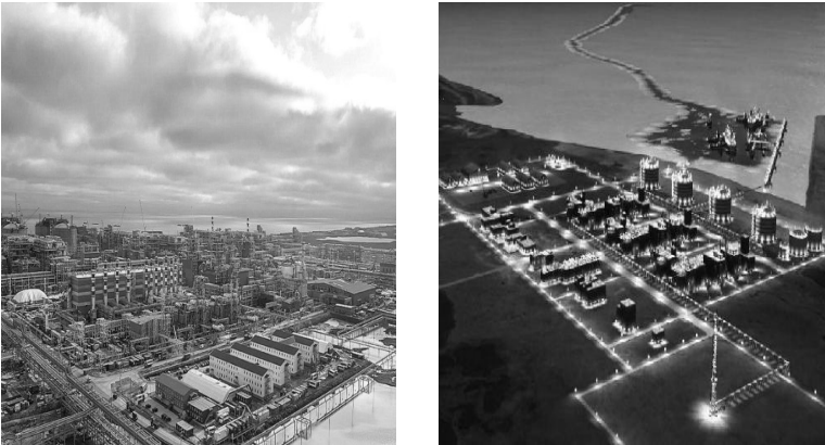
〈그림 2-6〉 야말 LNG 시설
