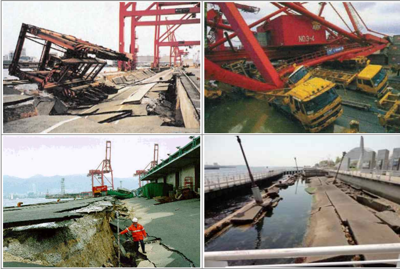
〈그림 3-4〉 대지진 고베항 항만시설 파손 현장
