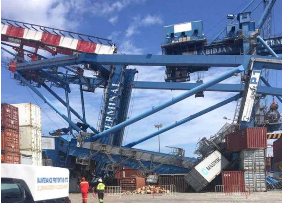
〈그림 2-5〉 아비장(Abidjan)항의 안벽크레인 붕괴사고
