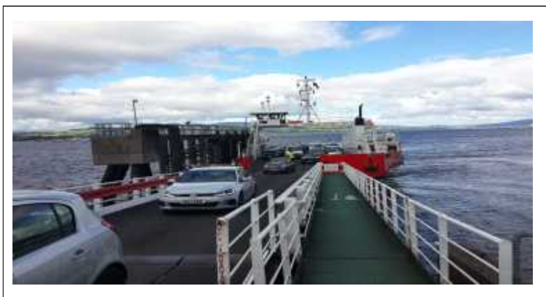
〈그림 3-32〉 스코틀랜드 구락(Gourock)의 유압식 승하선 설비
