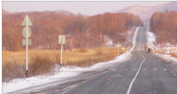
러시아 블라디보스톡-나홋카간 2차선 도로
