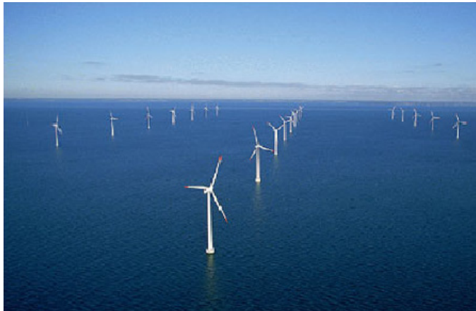
| 그림 3-29 | 해상풍력 발전설비 조감도
