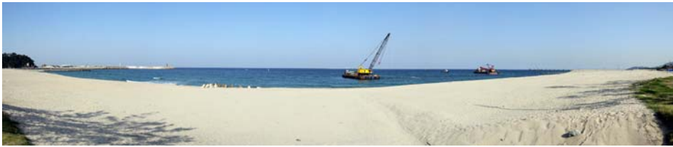
| 그림 2-7 | 양빈이 시행된 남항진 해안과 잠제가 설치되고 있는 모습
