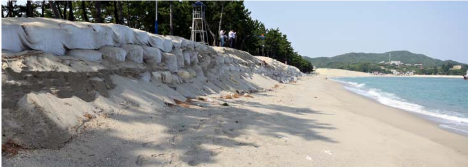
| 그림 2-5 | 궁촌 해안 주요 침식구역에 설치된 모래포대
