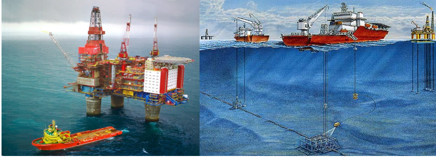
| 그림 2-31 | Cable, Pipe, Mooring 지원 작업 중인 OSV
