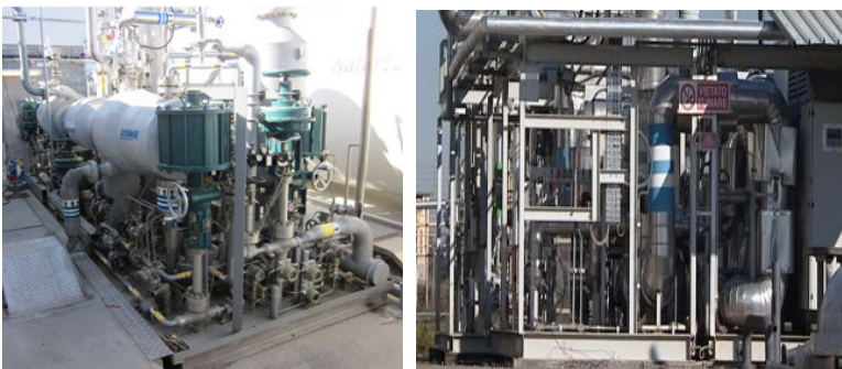
| 그림 2-34 | Marine LNG Engine and MFC
