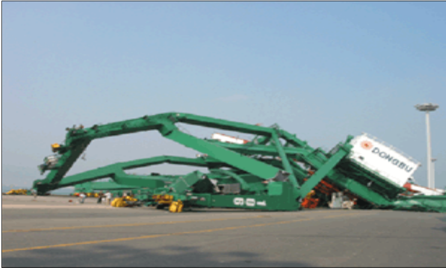
| 그림 2-6 | 신감만 부두의 붕괴된 컨테이너 크레인 전경(2)
