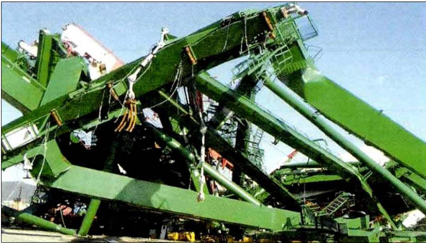
| 그림 2-5 | 신감만 부두의 붕괴된 컨테이너 크레인 전경(1)
