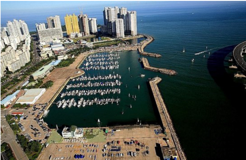
| 그림 3-8 | 부산 수영만 요트경기장 전경
