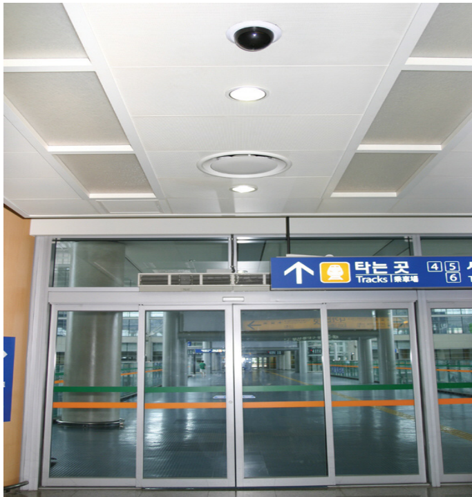
〈그림 5-6〉 역사 출입구 감시 시스템
