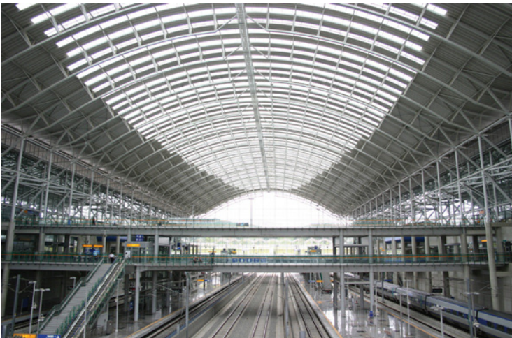
〈그림 5-5〉 철도역사 내부전경
