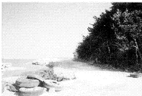
사진 7 방파제 연결도로 미비
