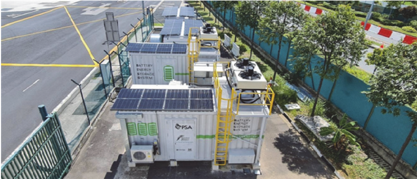
〈그림 3-9〉 파시르 판장 터미널의 ESS
