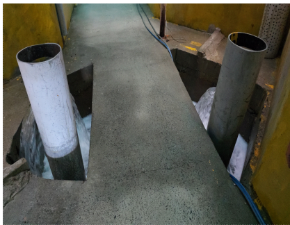
작업 및 이동 통로
