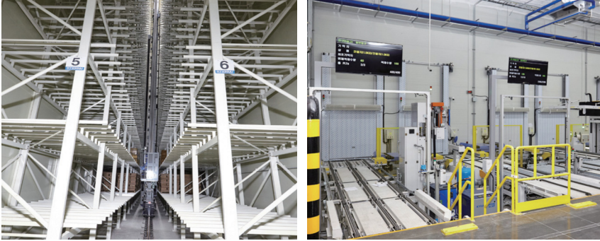
〈그림 2-13〉 동원로엑스 저온물류센터 자동화시설
