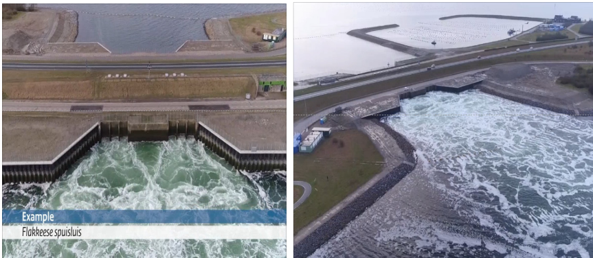
〈그림 3-21〉 휘어스호 하굿둑에 박스암거를 설치하여 해수를 유통하는 모습
