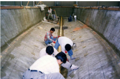
내부부재 취부 전 작업(7) (SANDING & MARKING)
